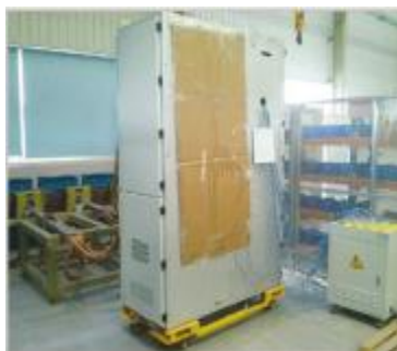
图2 12 kV/1 250 A 开关柜温升试验
